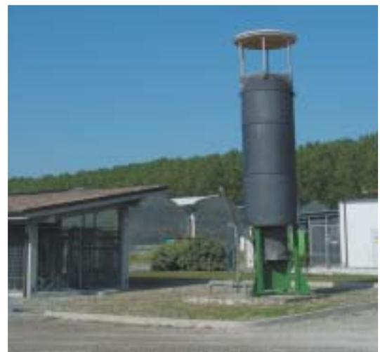
Fig.63 - Torcia per la combustione del biogas
