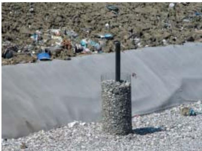
Fig.39 - Pozzo captazione biogas
