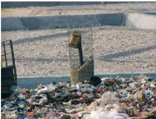
Fig.14 – pozzo captazione biogas
