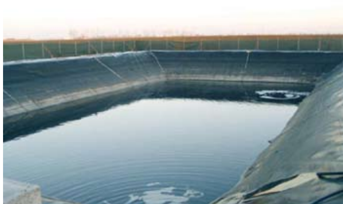
Fig.13 – vasca di accumulo del percolato
