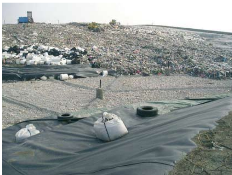
Fig.7 – operazione di compattazione dei rifiuti in discarica
