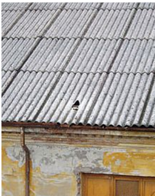
Un tetto coperto d'amianto
