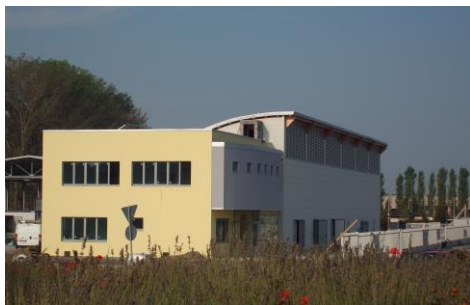
Centrale energetica EVA – En.cor. S.r.l. Correggio - RE
