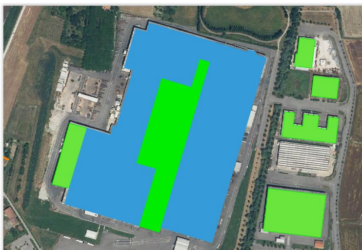
Figura 5 Aree bonificate di recente, probabile si tratti di fibrocemento senza amianto (verde) mentre la zona blu è stata ricoperta con Primer
