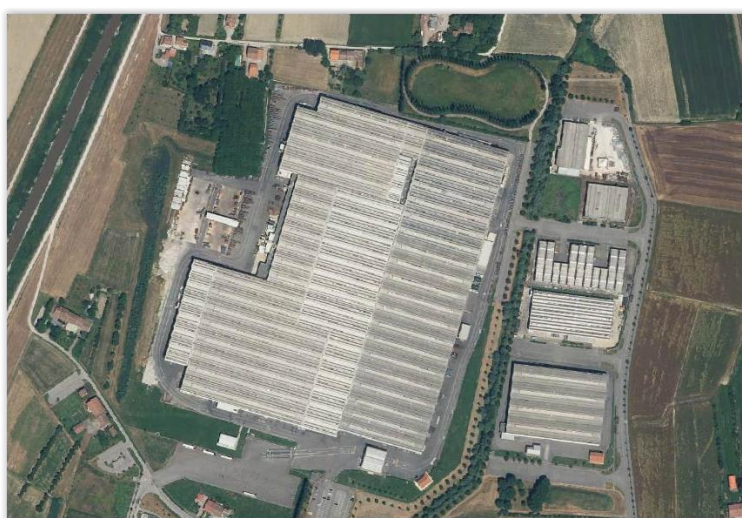
Figura 2 Copertura di oltre 80.000mq ricoperta con primer dopo il 2000
