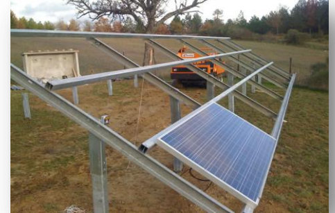
Figura 2.11: Strutture di sostegno
