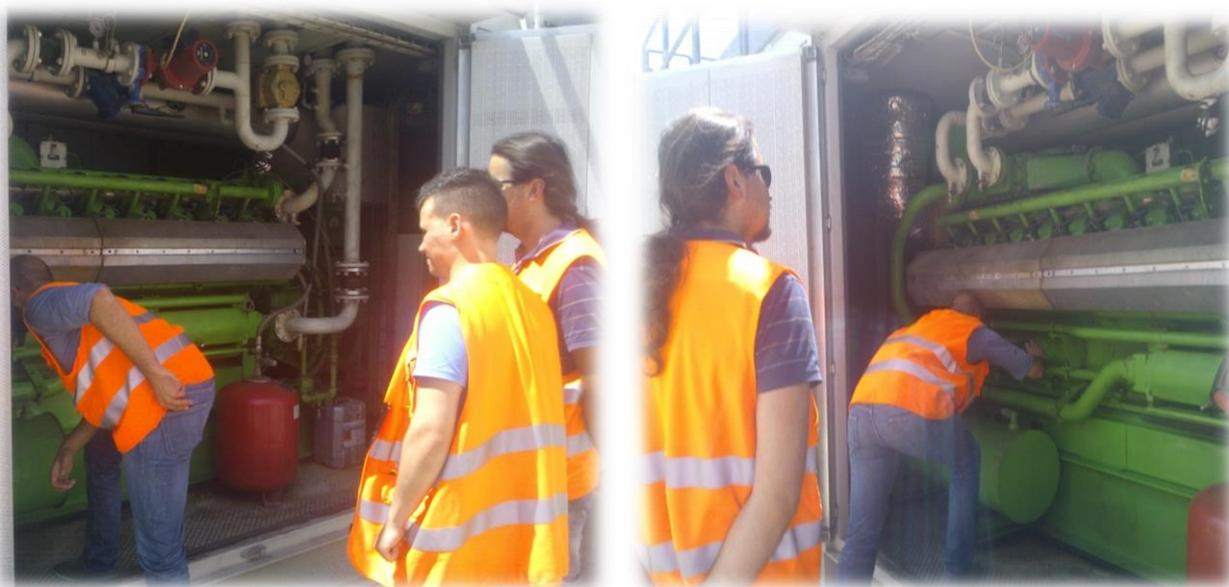
Figura 110 - Motori cogenerativi SINCRO 1.000 Gruppo GEJenbacher modello JGS 320 [S.A.BA.R., 2015]
