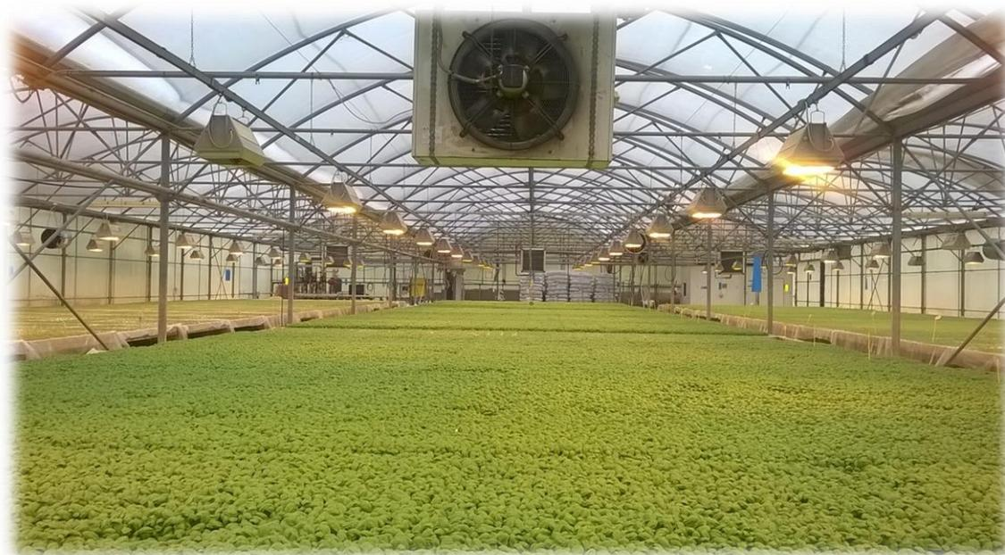
Figura 157 – Aerotermini che alimentano le serre esistenti [S.A.BA.R., 2015]
