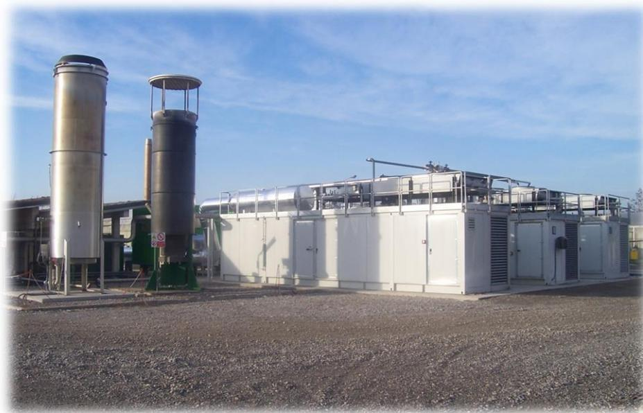
**Figura 106 – Foto della centrale di cogenerazione a biogas da discarica con i motori 6,7,8 [S.A.BA.R., 2015]**
