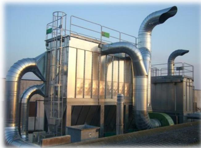
Figura 52 - linea d'abbattimento polveri nei fumi [Fumi, 2012]
