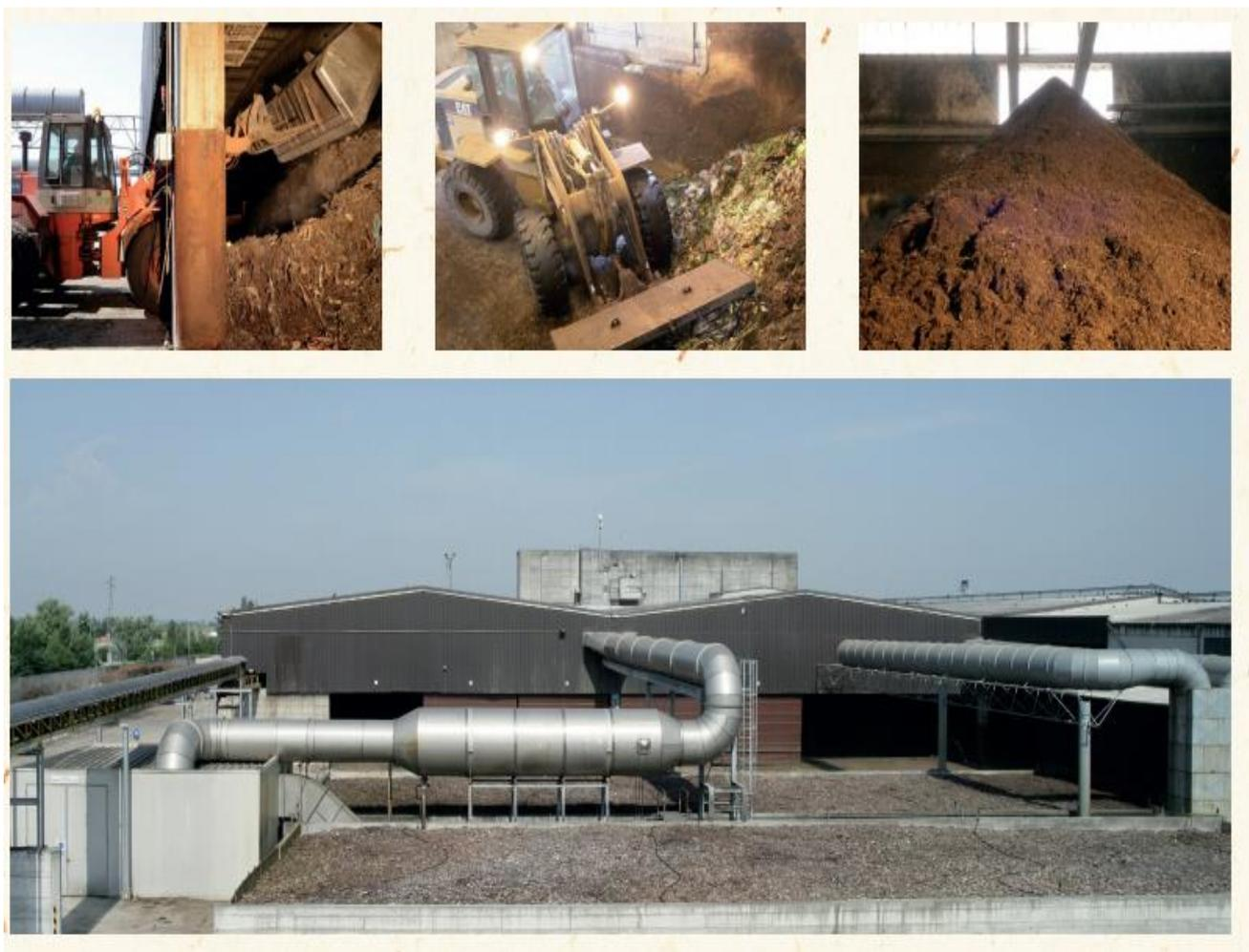
**Figura 173 - Componenti impiantistiche del centro di compostaggio AIMAG di Fossoli (in alto la movimentazione della miscela; sotto la linea di trattamento dell'aria: biofiltro)**
