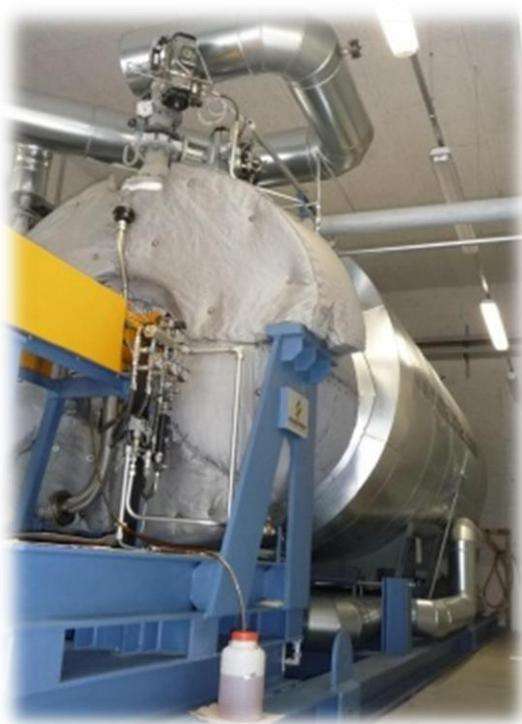
Figura 29 - Esempio di combustore a letto fluido alimentato da segatura [Camporeale e D. De Nigris, 2009]
