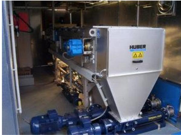
*Figura 25-Foto di un condizionatore per fango*
