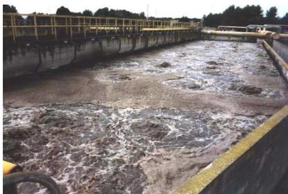
**Figura 14-Foto di un impianto a fanghi attivi**
