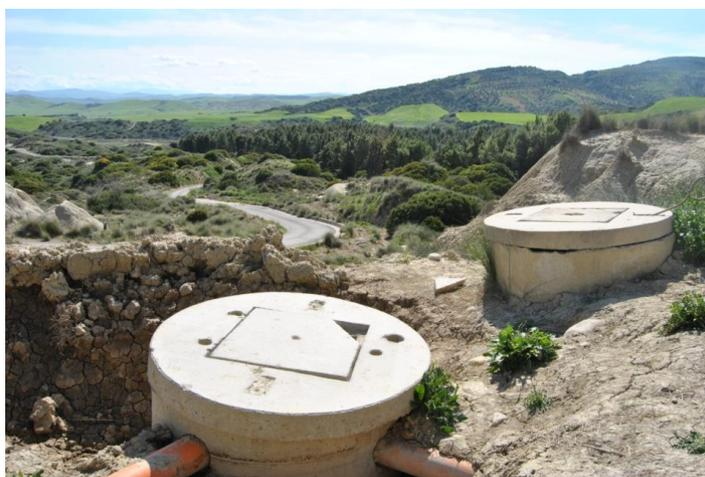
*Figura 37-Foto di un pozzo di raccolta del percolato*
