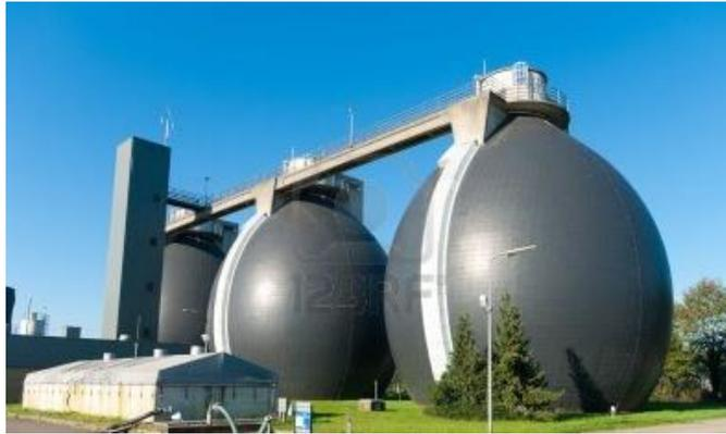
*Figura 59-Foto di un digestore*
