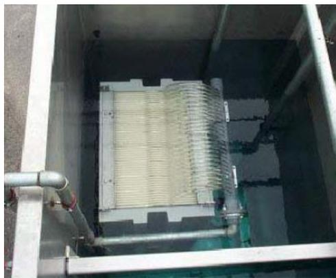
*Figura 48-Foto di membrana Plate and frame*
