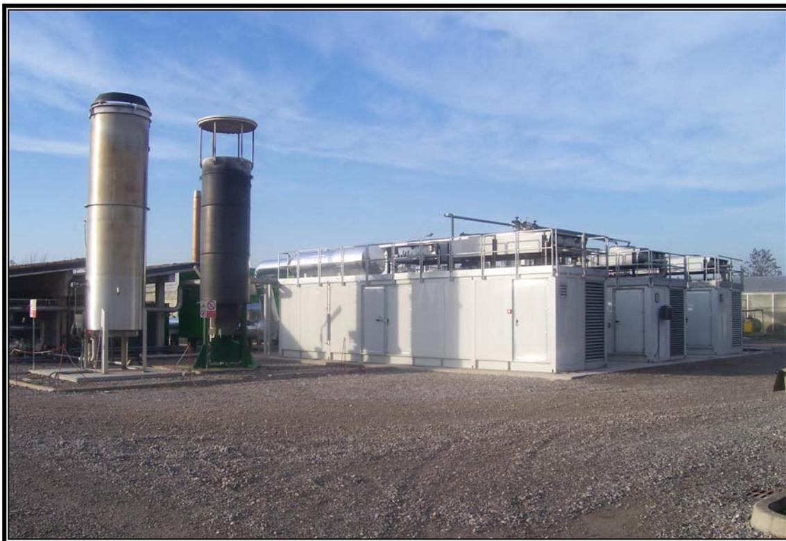
*Figura 25 - Immagine dei tre motori SINCR0 1.000 visti dall'esterno. Sulla sinistra si trovano le due torce*
