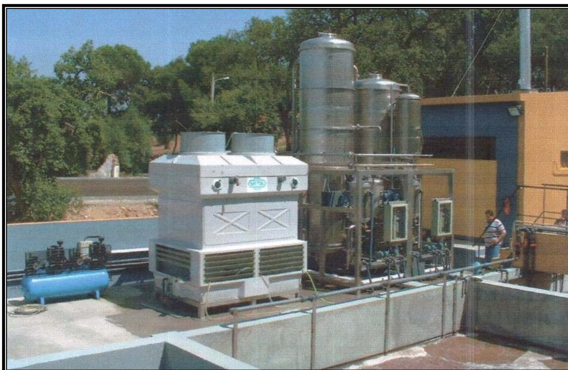
*Figura 94 - Immagine dell'impianto evaporatore ECO VS WW completo di torre evaporativa*
