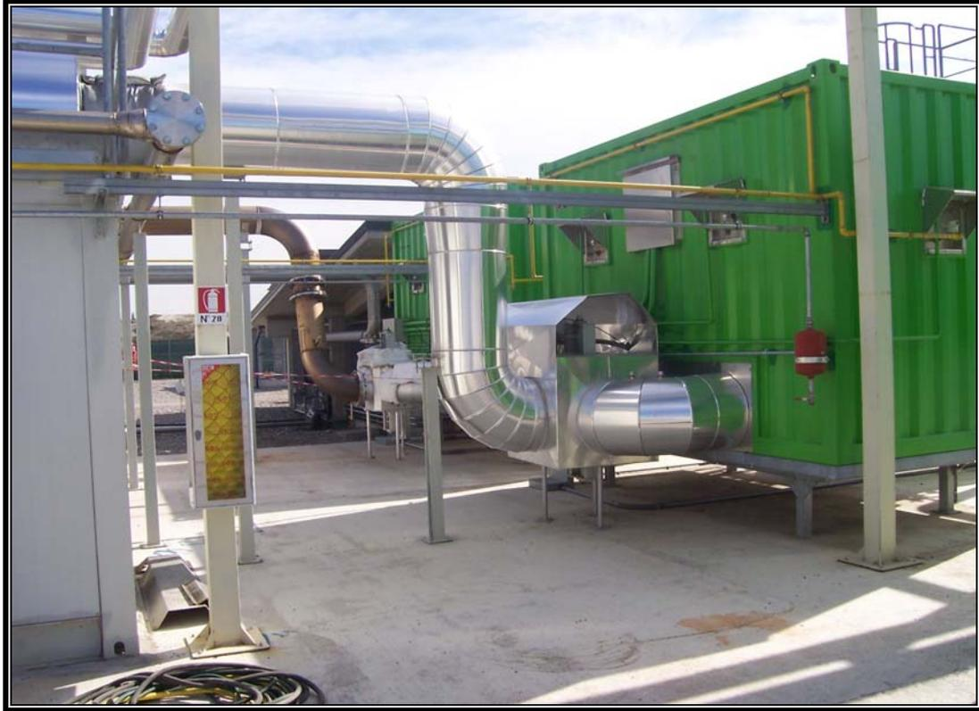
*Figura 26 - Immagine dei postcombustori posizionati a valle di ogni motore SINCRO 1.000*
