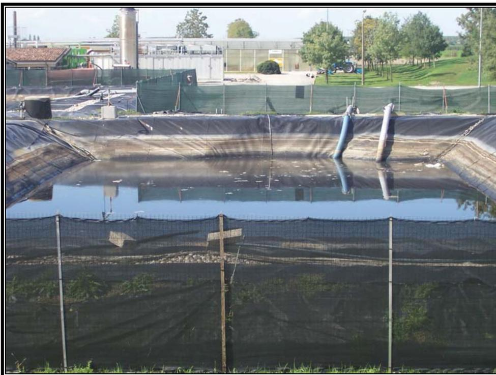
*Figura 8 - Vasca di raccolta del percolato presso la discarica di Novellara (S.A.B.A.R.)*
