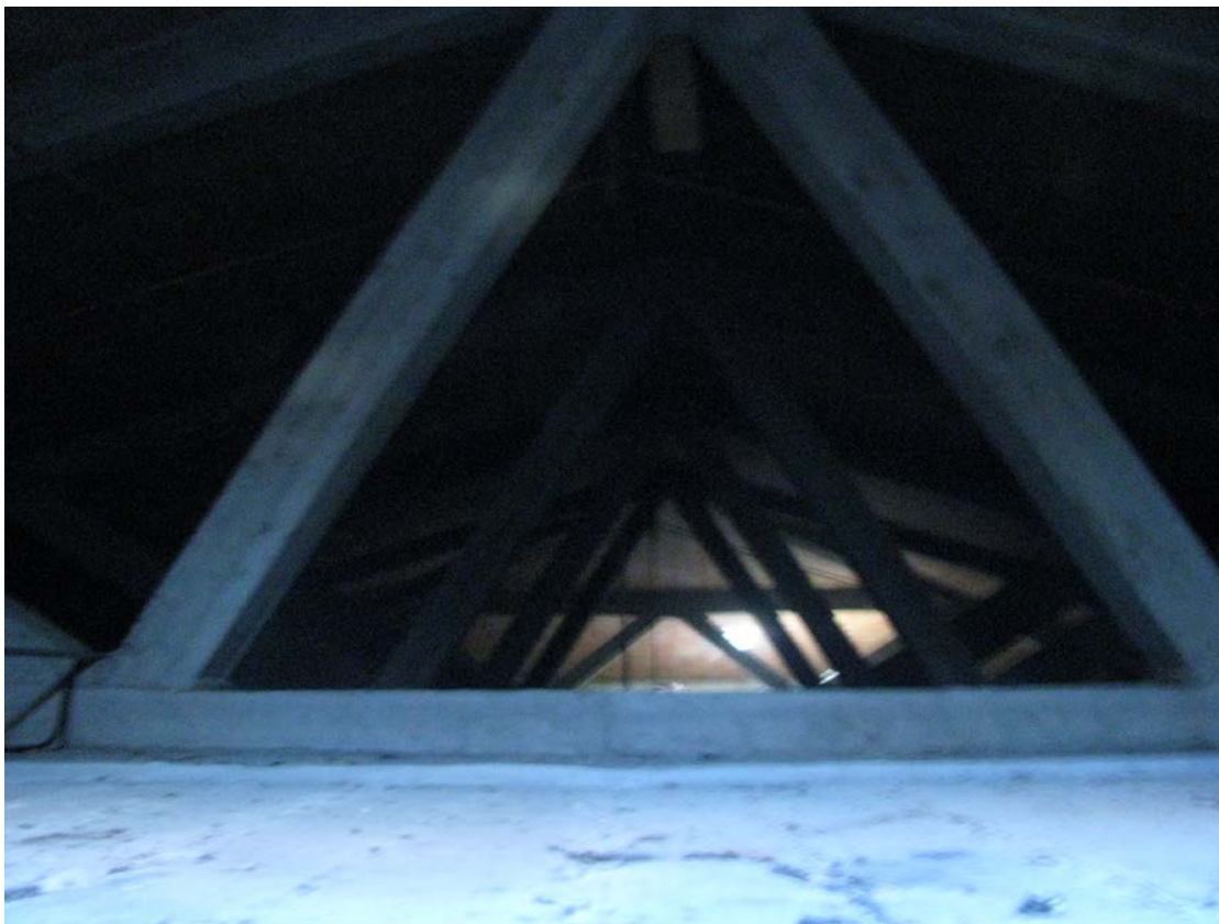
Figura 13 – Sottotetto della scuola in cui si prevede di inserire lo strato di isolante
