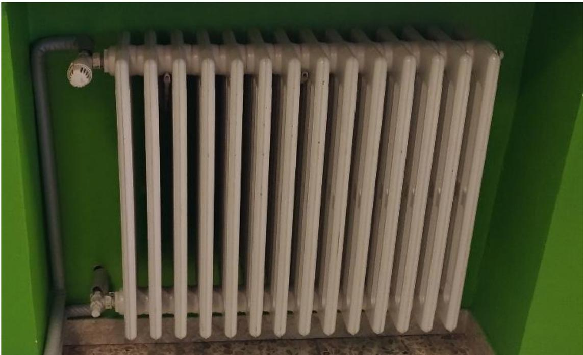
Figura 25. Corpo scaldante con valvola termostatica
