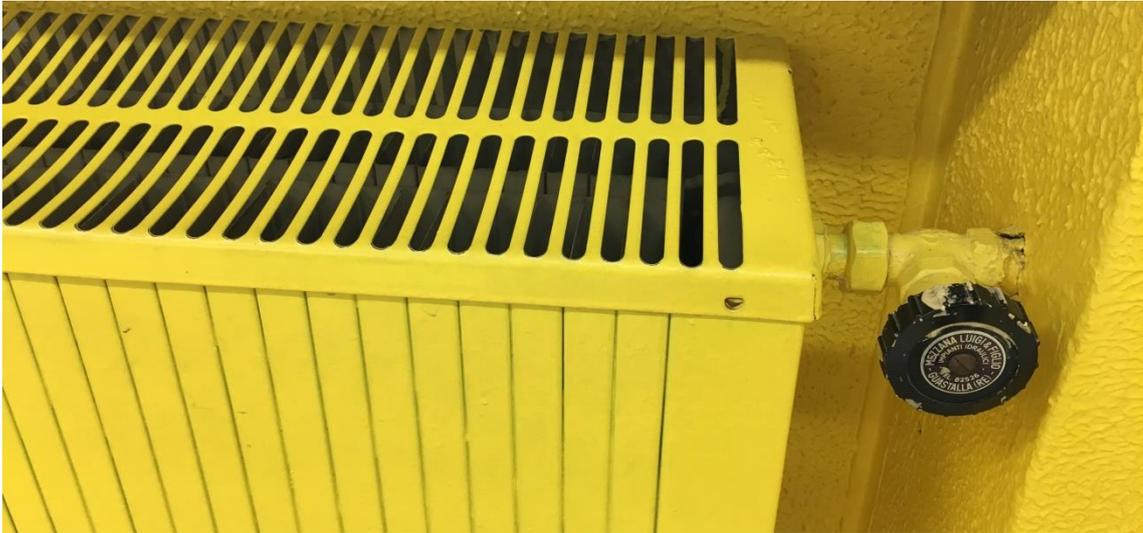
Figura 46. Corpo scaldante ante efficientamento senza valvola termostatica
