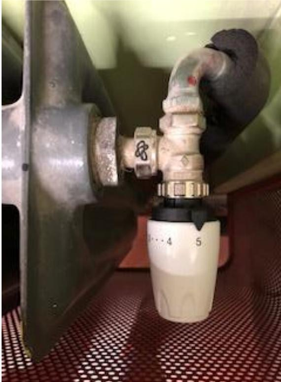
Figura 83. Valvola termostatica analogica a regolazione manuale
