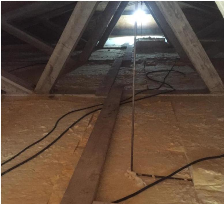
riscaldato, viene steso sull'estradosso del solaio piano del sottotetto uno strato di materiale isolante di lana di vetro di spessore pari a 14 cm, con trasmittanza termica pari a  $0,032 \text{ W/m}^2\text{k}$ , il quale permette di ottenere una trasmittanza termica complessiva del solaio pari a  $0,24 \text{ W/m}^2\text{k}$ . La superficie isolata riguarderà l'intera superficie della scuola, e risulta pari a  $1195 \text{ m}^2$ .
