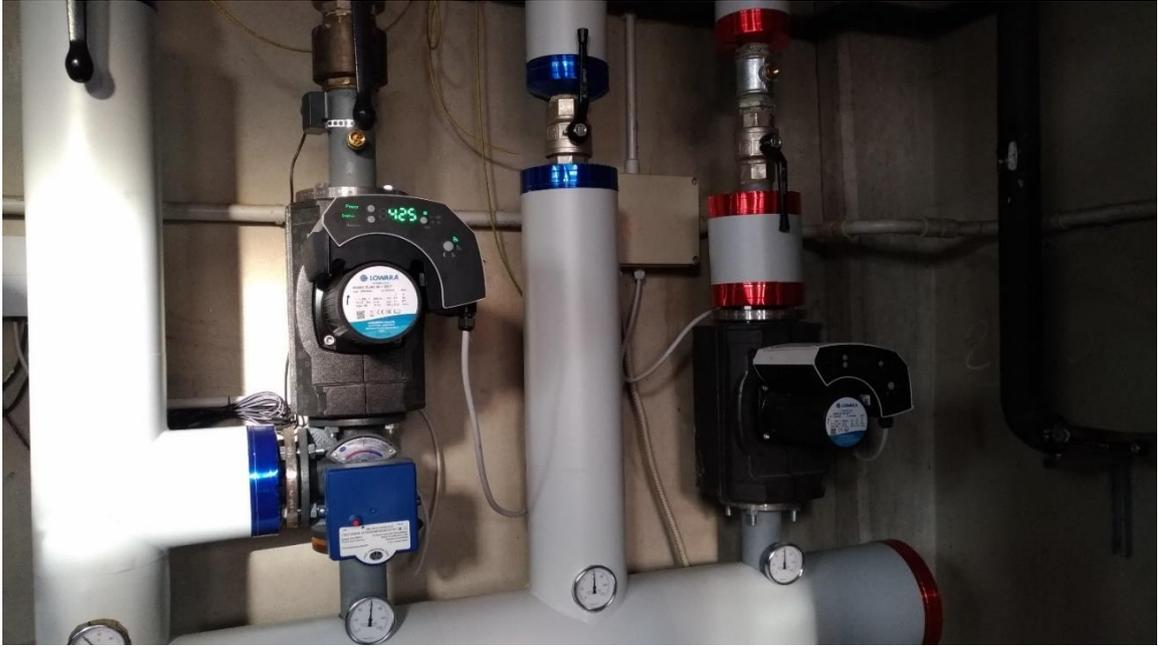
Figura 69. Nuovo sistema di distribuzione con pompe a giri variabili e valvole miscelatrici
