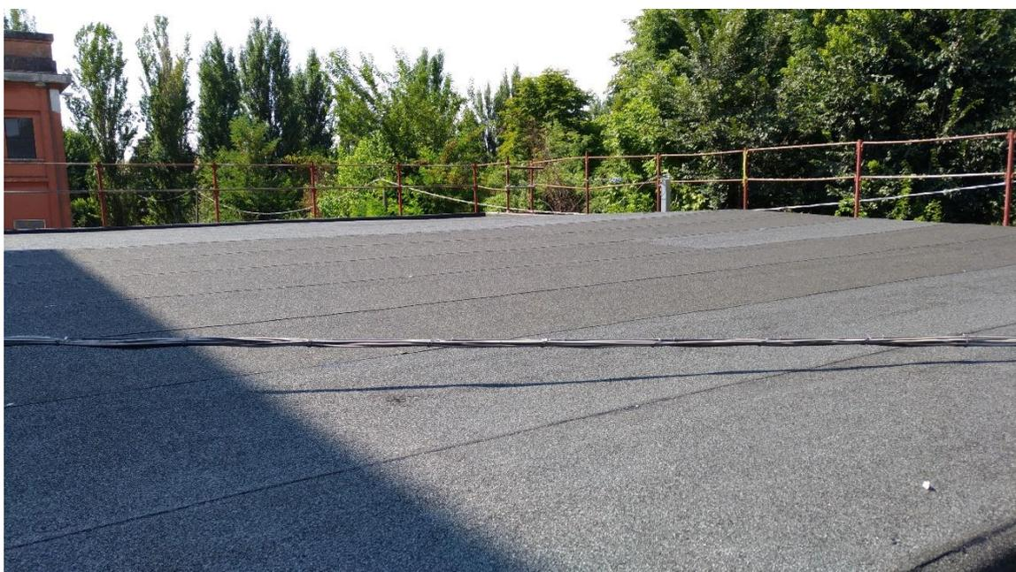
Figura 74. Copertura piana della palestra rivestita da membrana bituminosa
