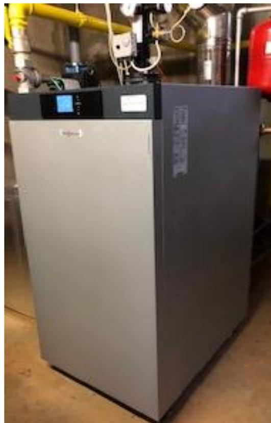
Figura 65. Caldaia a condensazione in centrale termica scuola
