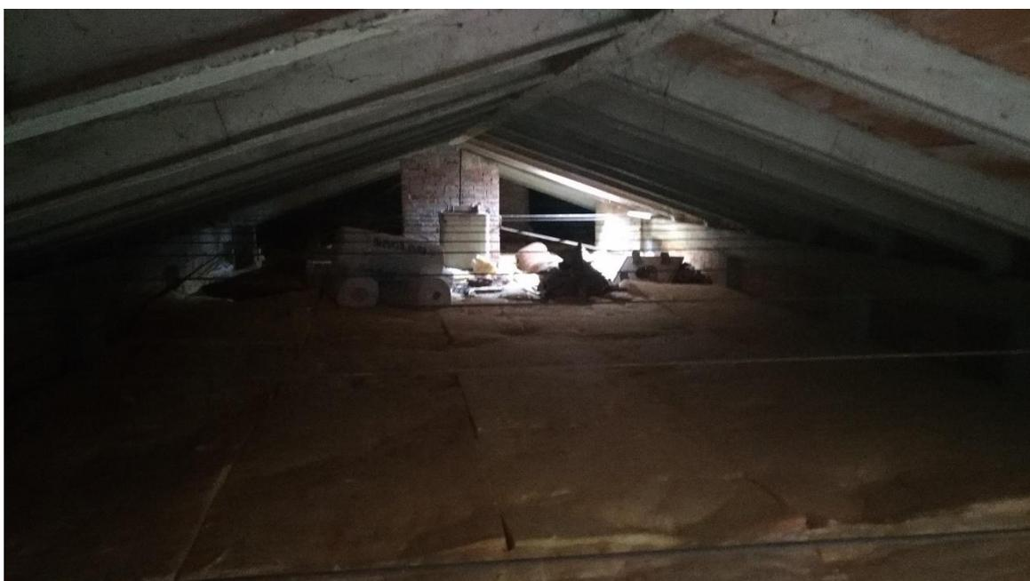
Figura 56. Solaio scuola coibentato con lana di vetro
