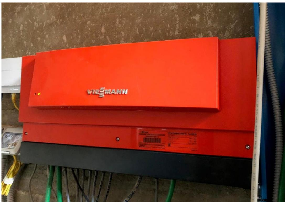
Figura 24. Centralina per il telecontrollo di una caldaia
