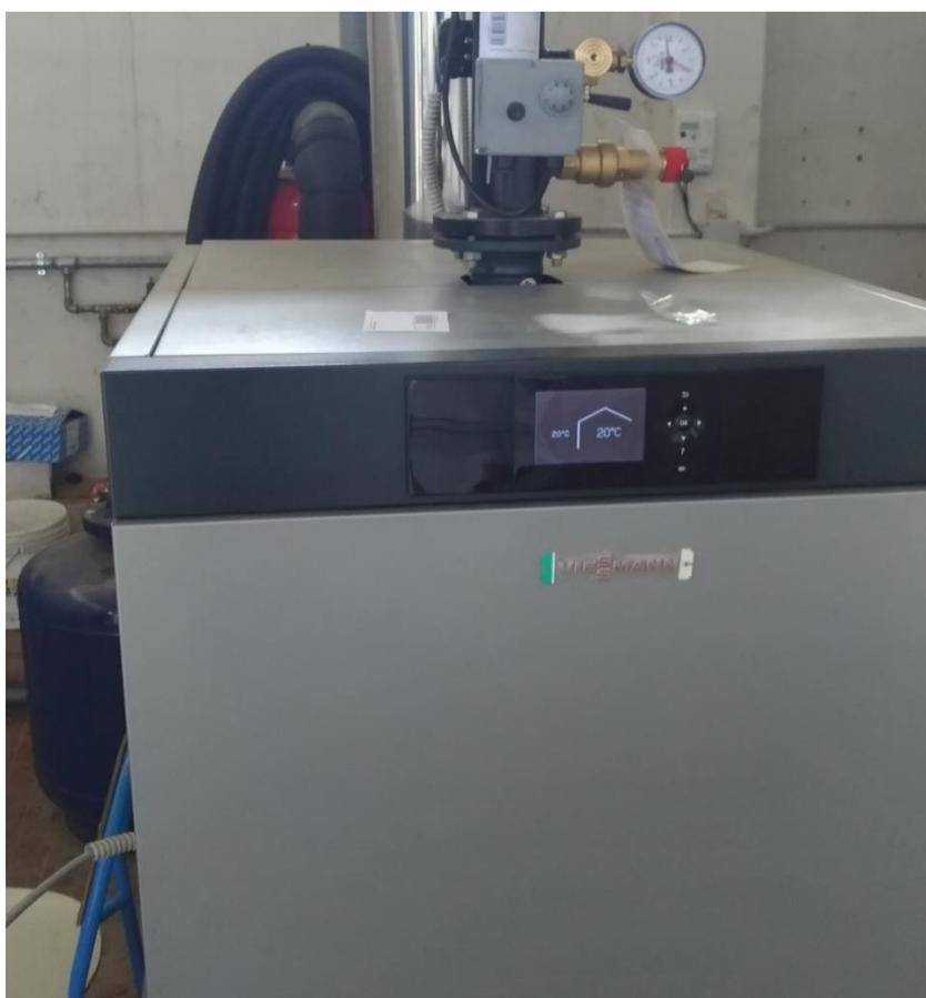
Figura 45. Generatore di calore a condensazione installato in centrale termica
