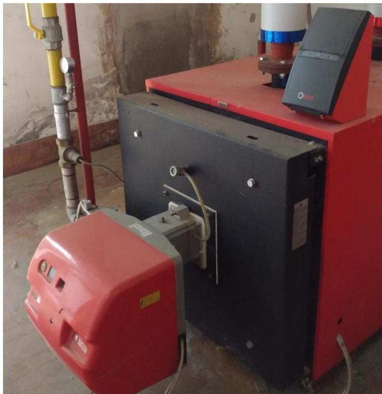
Figura 44. Generatore di calore a combustione ante efficientamento presente in centrale termica
