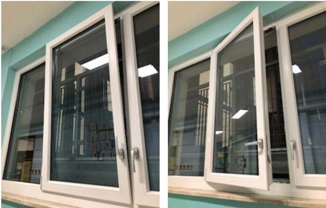
Figura 35. Serramenti in PVC post efficientamento
