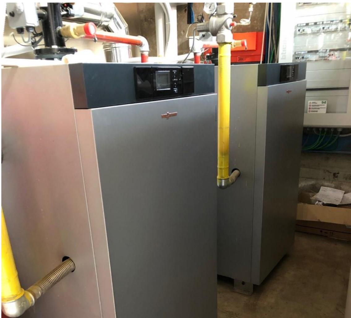
Figura 79. Nuovi generatori di calore a condensazione installati in centrale termica
