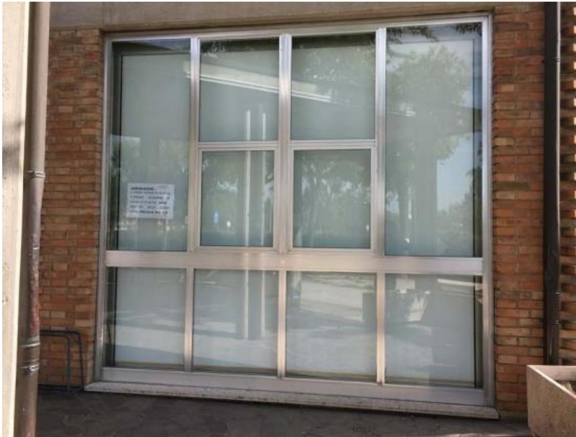
Figura 34. Serramenti in alluminio ante efficientamento
