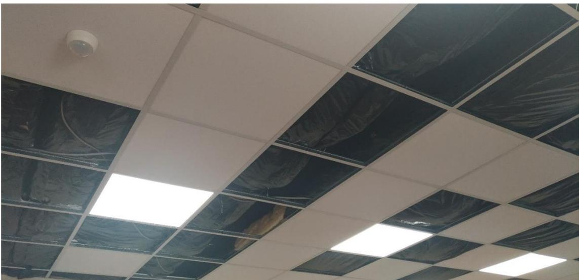
Figura 59. Controsoffitto coibentato con lana di vetro imbustata
