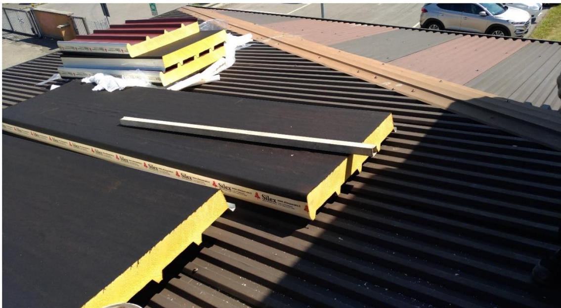
Figura 53. Pannelli a sandwich per la coibentazione della copertura spogliatoi
