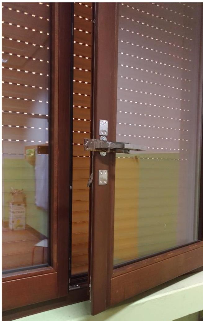
Figura 77. Nuovo serramento con vetrocamera installato nelle aule e particolare della maniglia in zama dei serramenti (non sostituita)
