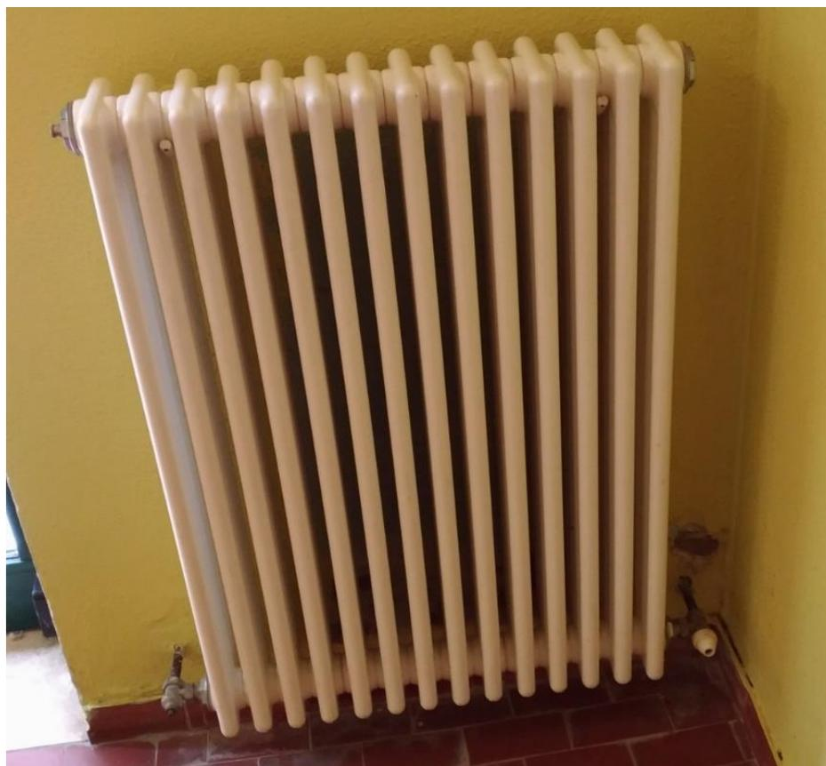
Figura 66. Radiatore della scuola senza valvola termostatica
