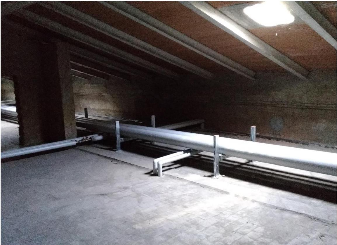
Figura 75. Estradosso del solaio con rete per riscaldamento (coibentata) senza applicazione lana di vetro
