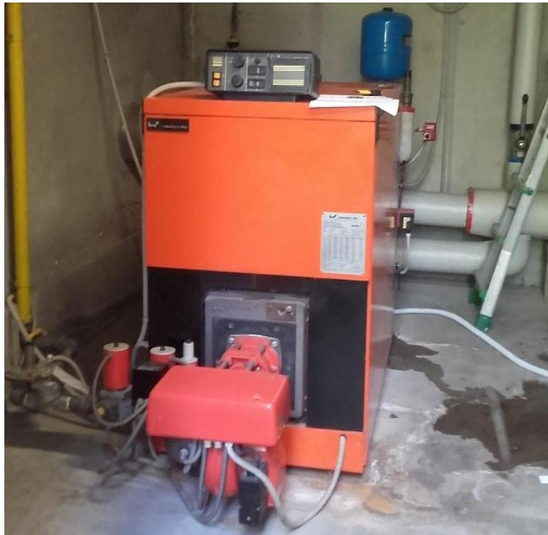
Figura 64. Generatore di calore a combustione ante efficientamento in centrale termica palestra
