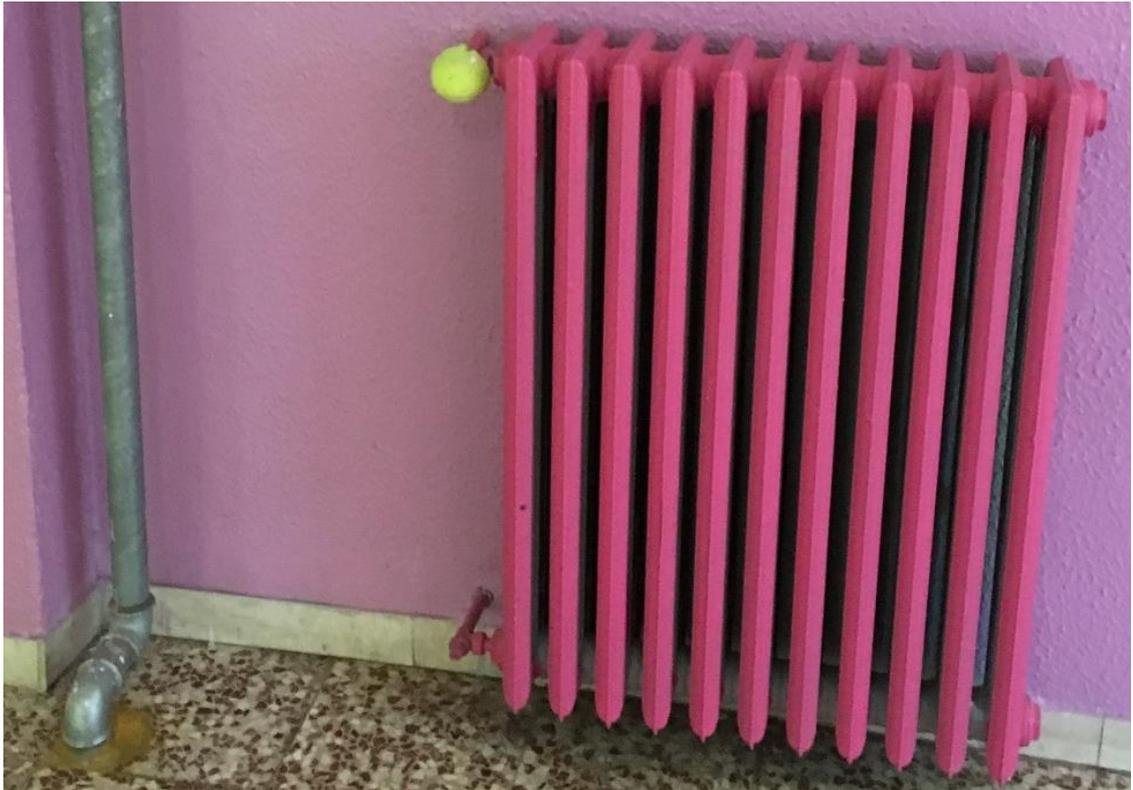
Figura 36. Corpo scaldante ante intervento senza valvola termostatica
