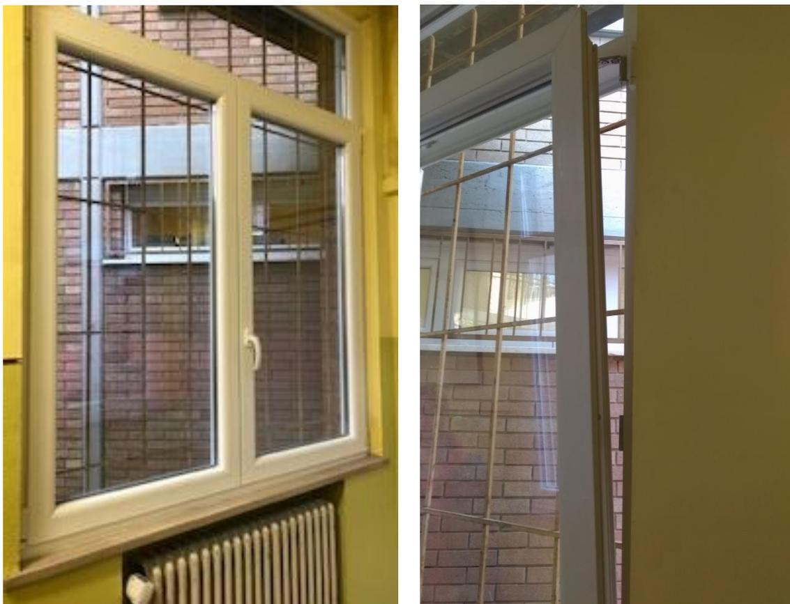
Figura 27. Nuovi serramenti in PVC, con vetrocamera
