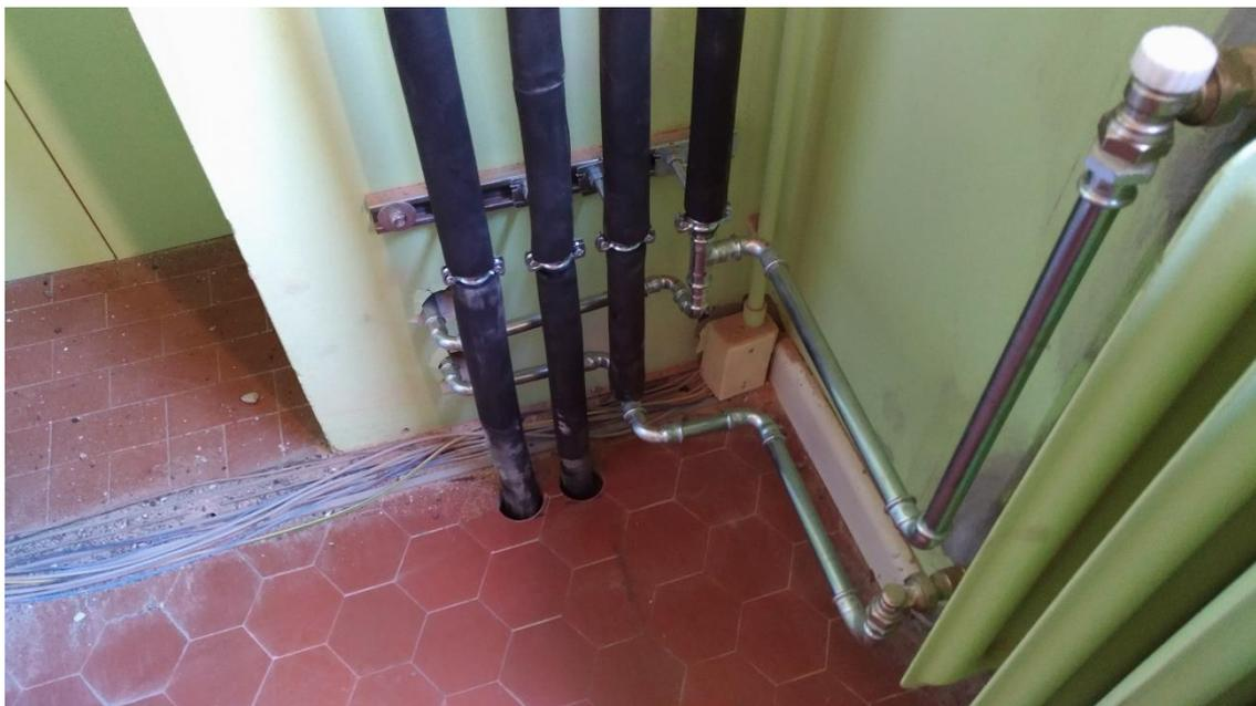
Figura 80. Carotaggi per il passaggio delle nuove tubazioni
