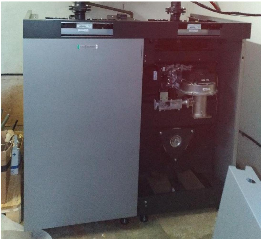
Figura 26. Generatore di calore a condensazione installato in centrale termica della scuola
