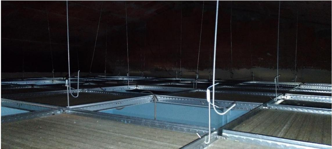
Figura 57. Realizzazione del controsoffitto mediante pannelli
