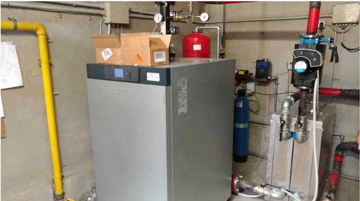
Figura 68. Generatore di calore a condensazione installato in centrale termica palestra
