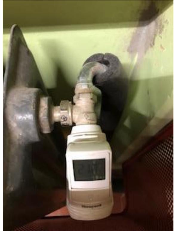
Figura 84. Valvola termostatica digitale a regolazione manuale o automatica
