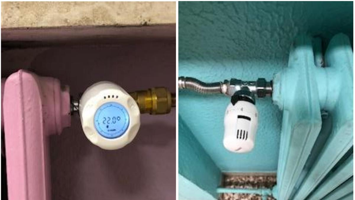
Figura 37. Valvole termostatiche installate, digitale e analogica
