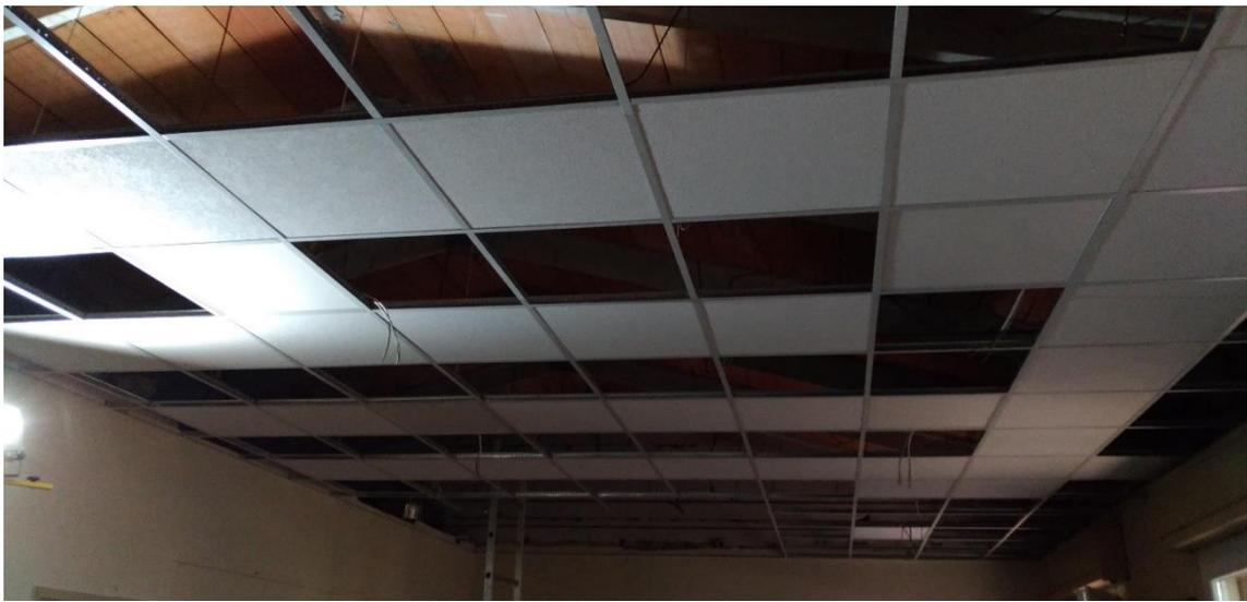
Figura 58. Realizzazione del controsoffitto mediante pannelli
