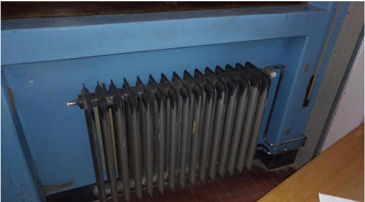
Figura 82. Corpo scaldante ante efficientamento senza valvola termostatica
