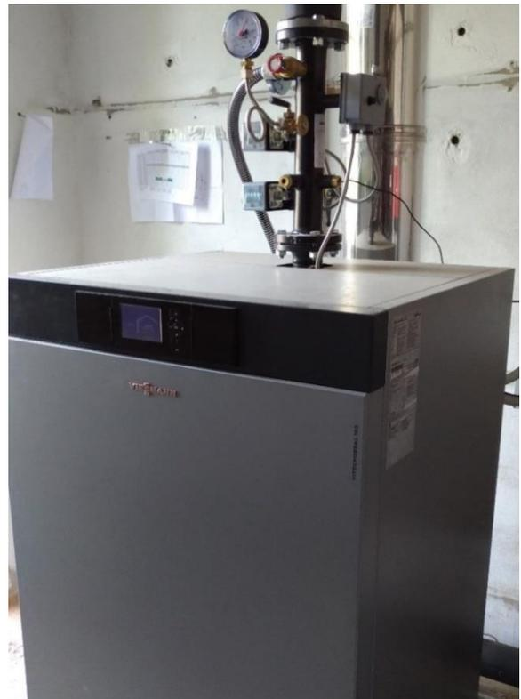
Figura 28. Generatore di calore a condensazione post intervento nella scuola
