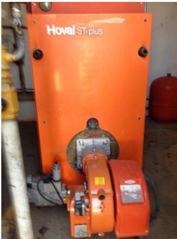
Figura 27. Generatore di calore a combustione ante intervento per la scuola
