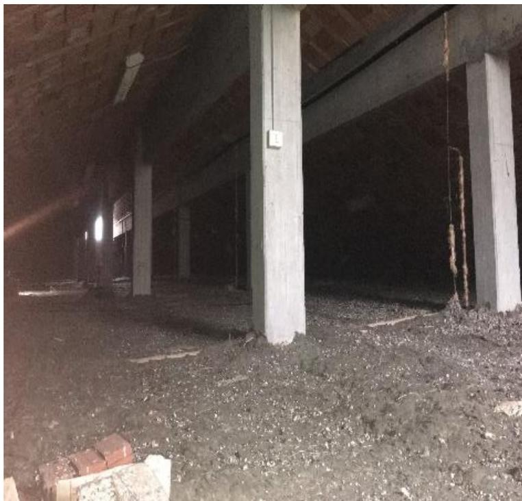
Figura 40. Estradosso del solaio ante intervento senza rivestimento
