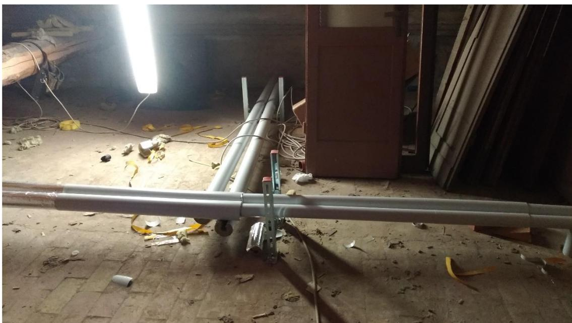
Figura 81. Nuova rete di distribuzione del circuito di riscaldamento coibentata e posizionata nel sottotetto
