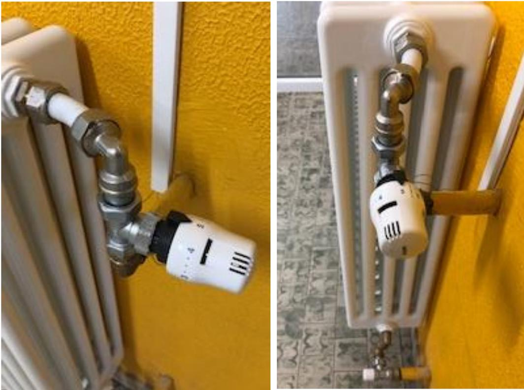
Figura 47. Nuovo corpo scaldante con valvola termostatica analogica
