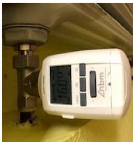
Figura 67. Corpi scaldanti con valvole termostatiche analogica manuale e digitale automatica
