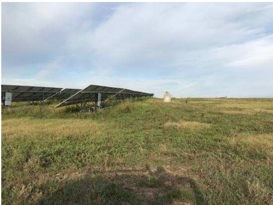
Area su cui si installerà l'impianto fotovoltaico
