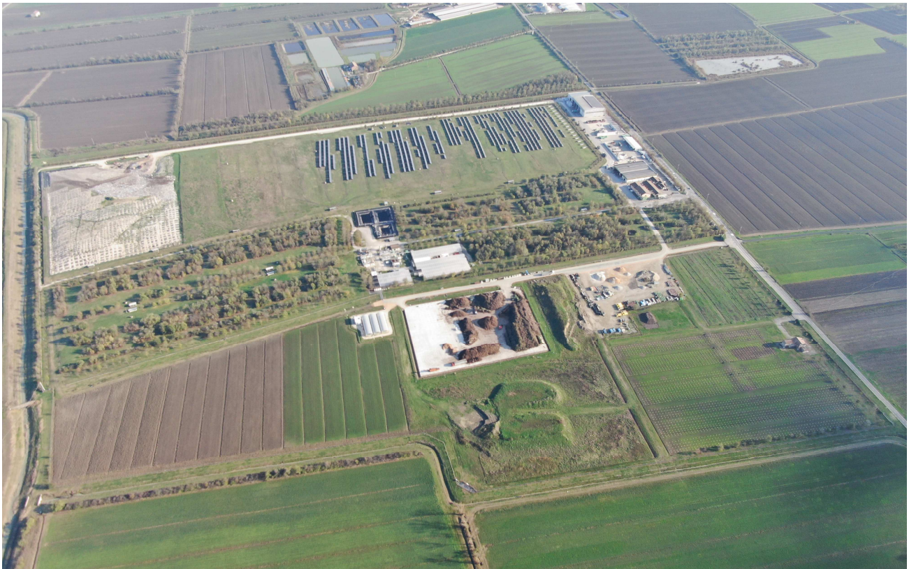
Figura 3 - Vista aerea del sito impiantistico di S.A.BA.R.
