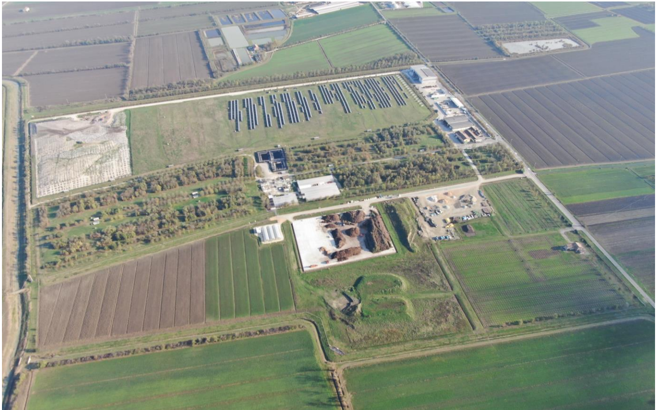
Figura 3 - Vista aerea del sito impiantistico di S.A.BA.R.
