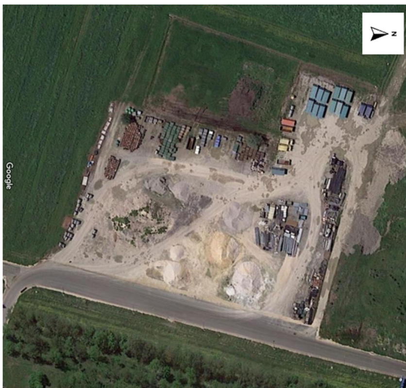
Fig. 3. Immagine tratta da Google dell'area oggetto di intervento
