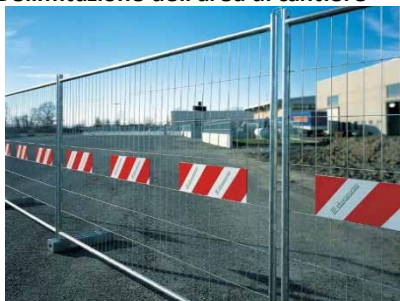
Rete metallica su basamento CLS
