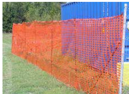
Rete plastificata con pali infissi nel terreno
