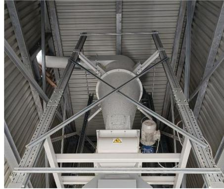
Figura 48. Il ciclone all'interno dell'impianto di depolverazione e rimozione dei metalli
