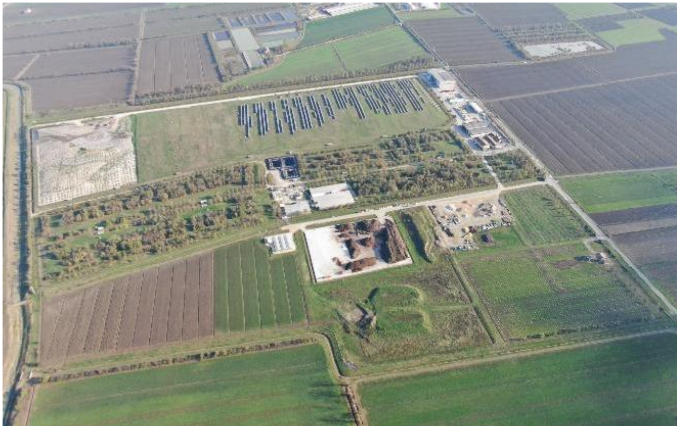
Figura 3 - Vista aerea del sito impiantistico di SABAR
